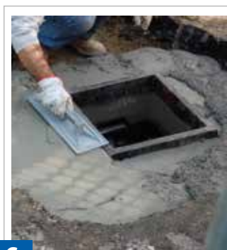
6 anello di supporto della griglia in cemento
