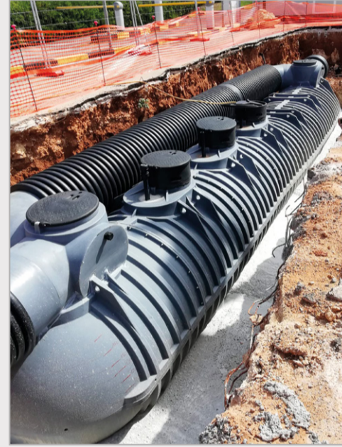
نظام الترشيح Leaching system
