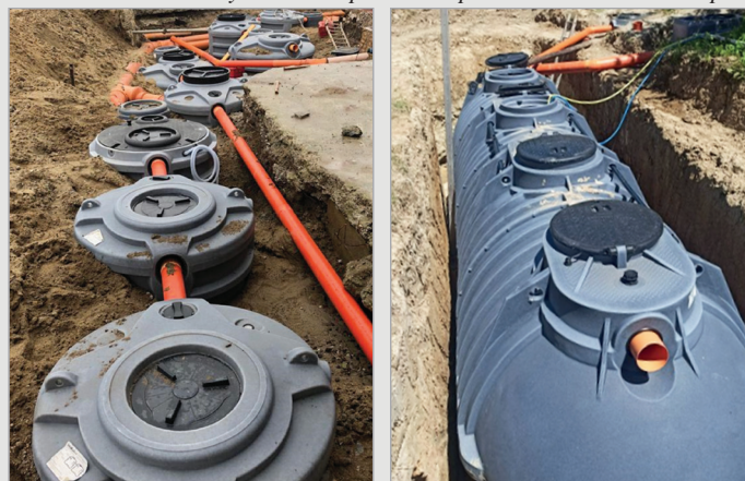
Installation de deux systèmes: le premier séparé et le deuxième compact
