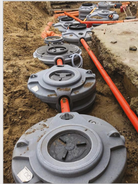
Installazione di due impianti: il primo separato e il secondo compatto Installation of two systems: the first separate and the second compact.
