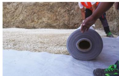
Nei sistemi di accumulo dove è previsto l'avvolgimento del bacino con geomembrana in HDPE, proteggere lo stesso sia all'esterno che all'interno con TNT da 200 g/m<sup>2</sup> minimo. Quindi in ordine si stende: TNT / geomembrana / TNT.
